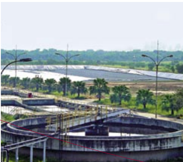
Estação de Tratamento de Efluentes, em Guaratinguetá Estación de Tratamiento de Efluentes, en Guaratinguetá
