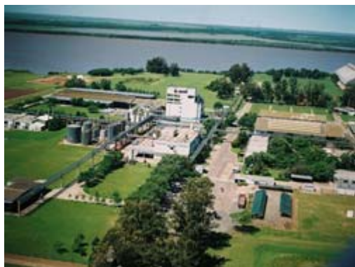
Planta Industrial Lagos, Rosario, Sta. Fe.
